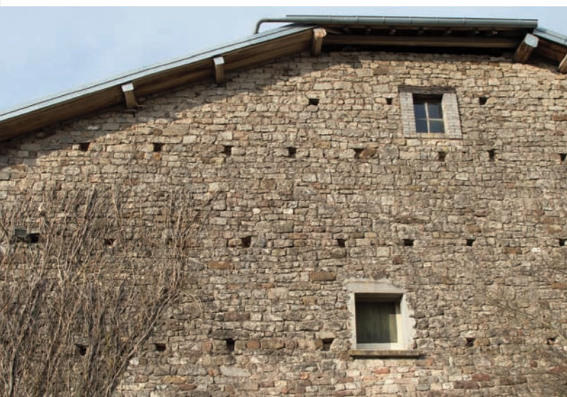
Les anfractuosités laissées volontairement dans cette façade constituent autant de sites potentiels de nidification pour les espèces semi-cavernicoles, telles que les rouges-queues, bergeronnettes et autres gobe-mouches gris. © Philippe Moës
