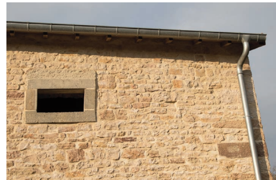
Dans les bâtiments nouvellement rénovés ou construits, il est également possible d'aménager un passage pour les oiseaux pouvant nicher à l'intérieur, comme ici une ouverture à l'intention des hirondelles rustiques (à gauche) et de la chouette effraie (à droite). © Philippe Moës
